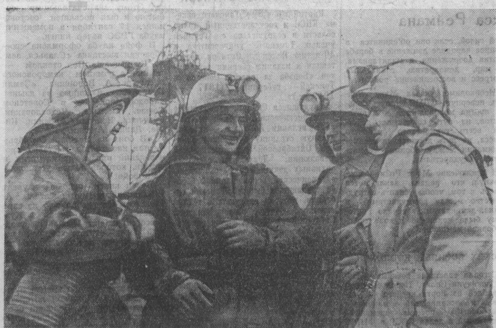
Высокой выработкой добиваются проходчики на строительстве шахты «Егоровская-1» в городе Ленинск-Кузнецком. На участке № 1 150—160 процентов. НА СНИМКЕ передовики проходки (слева направо): А. И. МУСТАФИН, А. П. УСТИНОВ, Н. И. МАЛЯВИН, И. К. ЛЕВШАКОВ.
