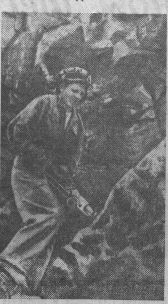
Для укладки полотна приходится «добывать» грунт. «Добывать» — это значит взрывать скалы. Здесь иней грунт не встречается. Проходчик Леонид Пуенков готовит на участке Шоры — Чарыш к взрыву каменную глыбу.
