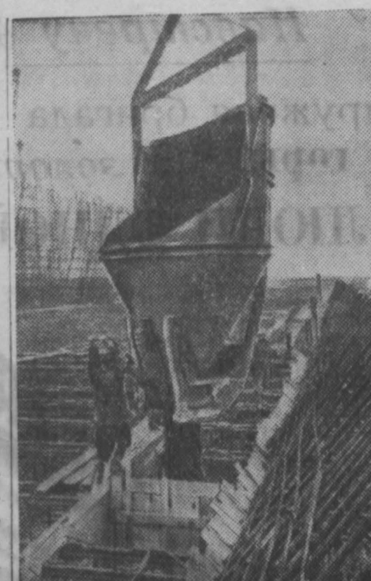
Высокими темпами идет сооружение Сталинградской гидроэлектростанции. В честь 40-й годовщины Великого Октября строители взяли обязательство к 7 ноября этого года уложить в основные гидросооружения 1 миллион 600 тысяч кубометров бетона, а в том числе в шлюзы — 425 тысяч кубометров.
