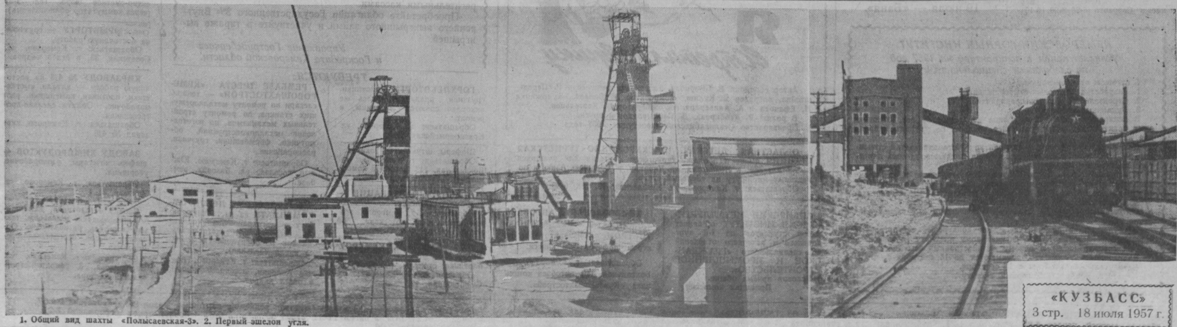
1. Общий вид шахты «Полысаевская-3». 2. Первый швелер угля.
