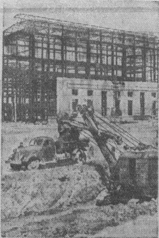
Казахская ССР. На строительной площадке Карагандинского металлургического завода сооружается ТЭЦ. В третьем квартале этого года здесь начнется монтаж оборудования.
