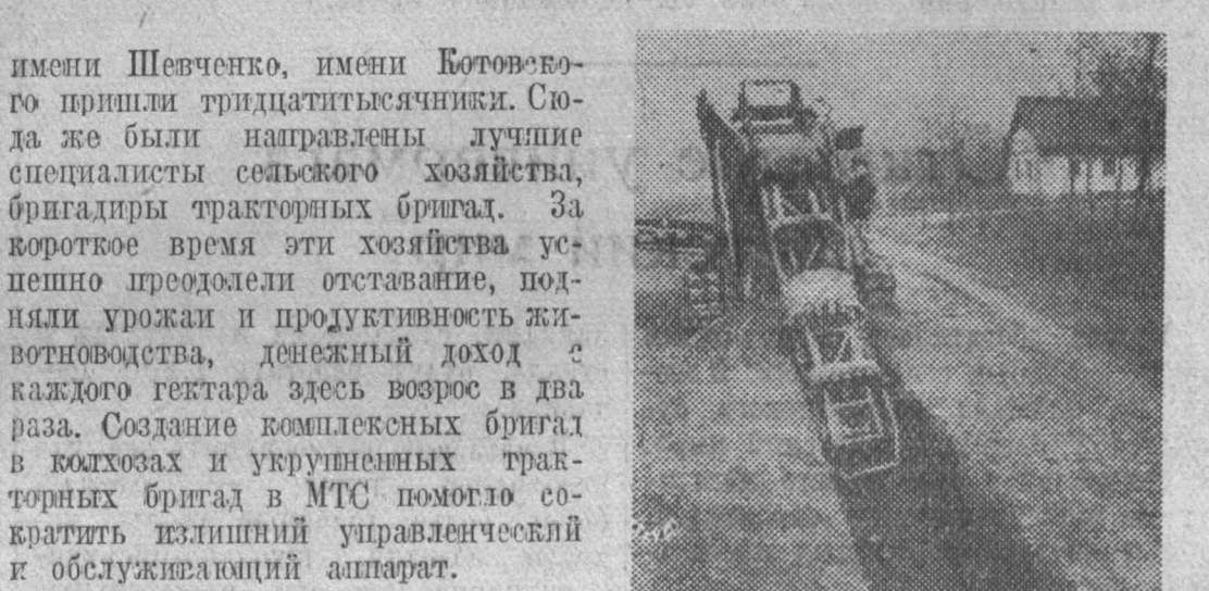
Механизаторы МТС имени Шевченко ведут рытье траншей для прокладки водопровода в колхозе имени Богдана Хмельницкого Березовского района.
