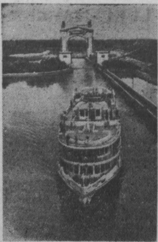
Сталинградская область. Дизель-электростанция «Латвия» вывезена из-под Волго-Донского канала имени В. И. Ленина.
