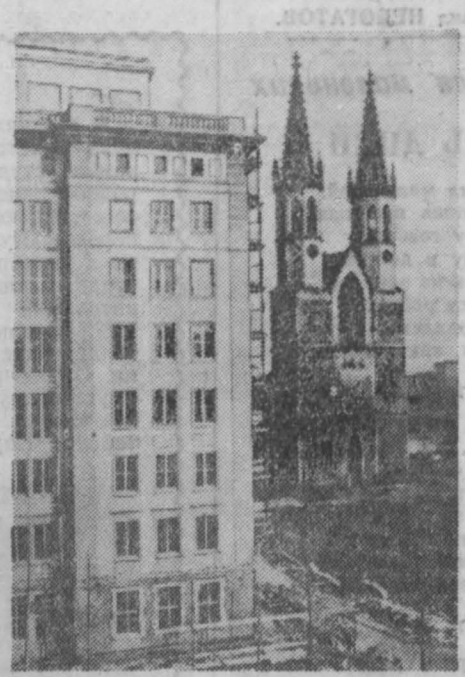
Германская Демократическая Республика. Строительство дома в Магдебурге. Фото Центральбюро.
