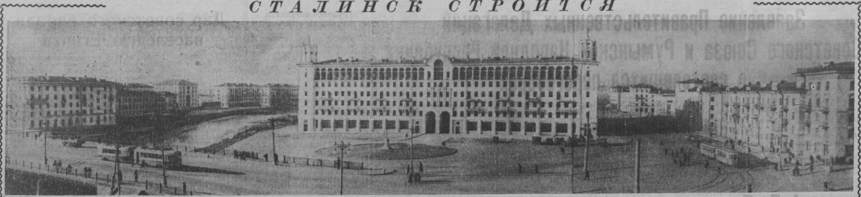
Хорошеет и благоустраивается город Сталинск. НА СНИМКЕ: участок города в районе нового моста.
