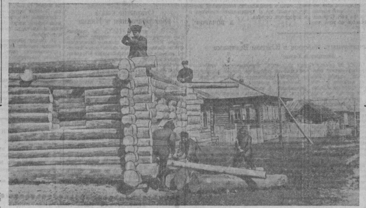
НА СНИМКЕ: строительство домов колхозников в сельхозартели «Гигант», Юргинского района.
