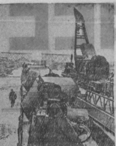
Братск. В октябре строители Братской ГЭС получили 1.000 тонн различных грузов. Среди них — оборудование и машины...
