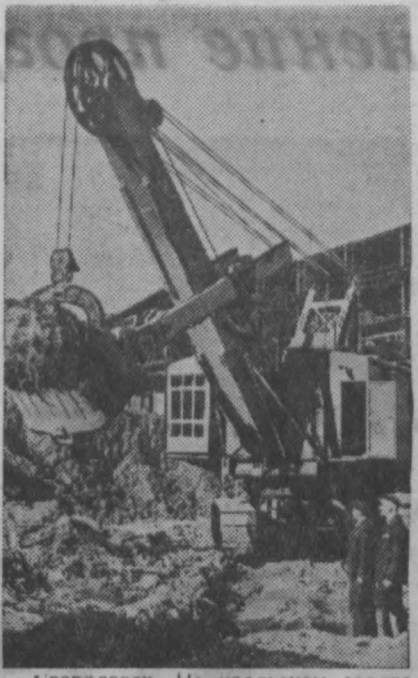
Свердловск. На уральском заводе тяжелого машиностроения собрана партия новых землеройных машин типа «ЭКГ-4». Этот экскаватор в отличие от «СЗ-3» более емко — 4 кубометра, стрелу новой конструкции.
