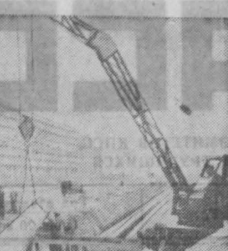
Красноярск строится. Незунаваемо изменился правый берег Енисея, где расположились десятки крупных индустриальных и промышленных предприятий. Здесь появились новые кварталы жилых домов, созданы новые улицы и проспекты. Сейчас идет прокладка теплофикационных магистралей для централизованного отопления вновь строящихся кварталов преобреежья.
