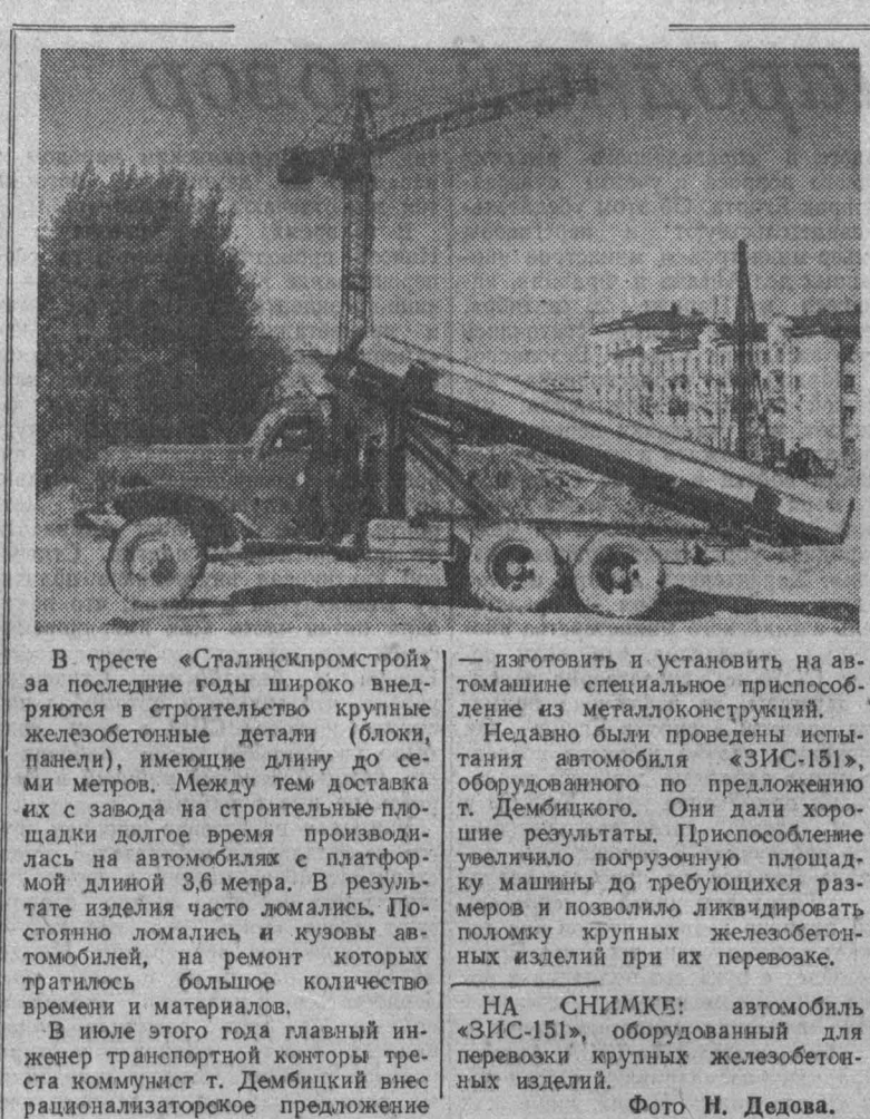
В тресте «Сталсепромстрой» за последние годы широко внедряются в строительство крупные железобетонные детали (блоки, панели), имеющие длину до семи метров. Между тем доставка их с завода на строительные площадки долгое время производилась на автомобилях с платформой длиной 3,6 метра. В результате изделия часто ломались. Постоянно ломались и кузова автомобилей, на ремонт которых тратилось большое количество времени и материалов.
