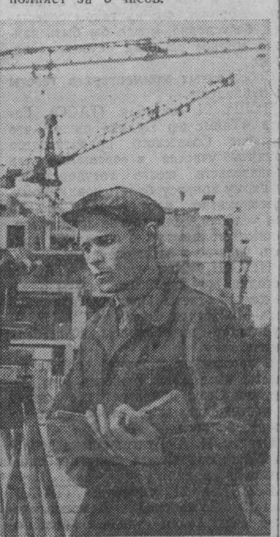
Топограф-геодезист И. А. Шильков внимательно следит за правильностью установки блоков.
