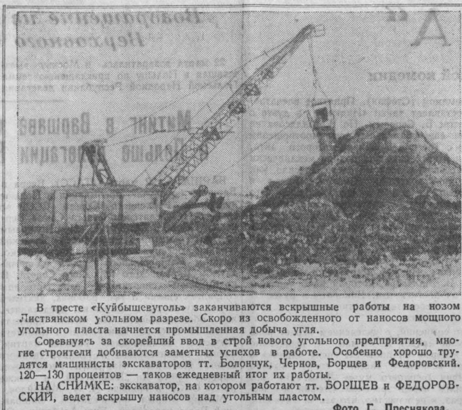
В тресте «Куйбысуголь» заканчиваются вскрышные работы на нозом Листьянском угольном разрезе. Скоро из освобожденного от наносов мощного угольного пласта начнется промышленная добыча угля.
