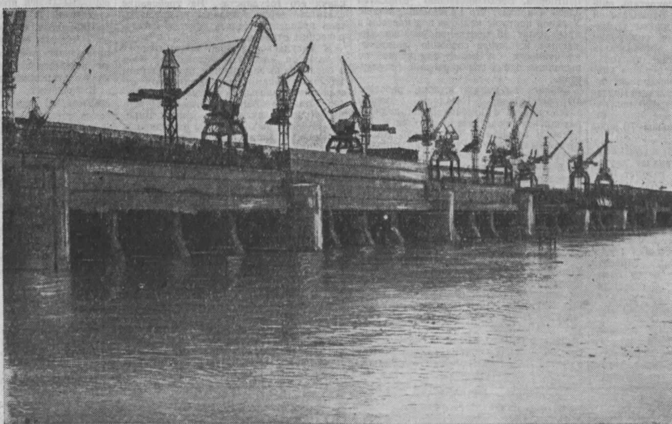
Жигулевск. Вид на строительство Куйбышевской ГЭС после затопления котлована.
