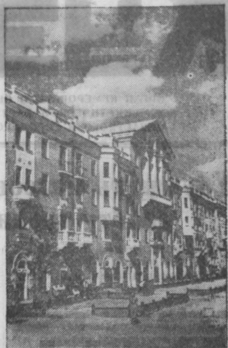
Брянская область. Ежегодно в городе Бежице для брянских паровозостроителей возводятся жилые дома. С начала года паровозостроители получили 1.700 квадратных метров жилой площади. НА СНИМКЕ: новый 71-квартирный дом брянских паровозостроителей на Ростовской улице.
