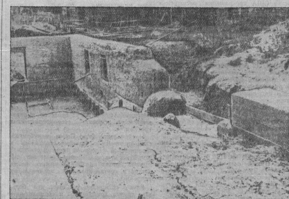
Так выглядит сейчас фундамент школы на 880 мест, заложенный осенью 1953 года в Осининском строуправлении № 6.
