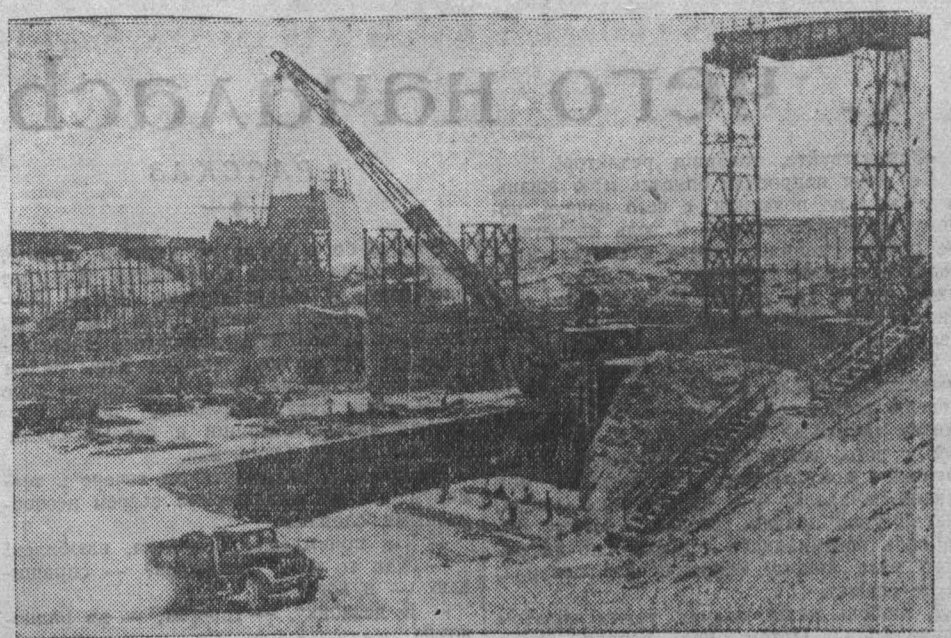
Таджикская ССР. Строительство Кайракумской гидроэлектростанции на реке Сыр-Дарье.
