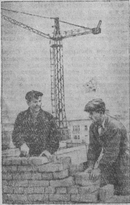
В центре города Ленинска-Кузнецкого развернулось сооружение многостажных жилых домов. Хорошо трудится на строительстве 56-квартирного дома комплексная бригада Петренко из Колыунигского стройуправления. Камешники на кладке здания выполняют нормы на 160—180 процентов.
