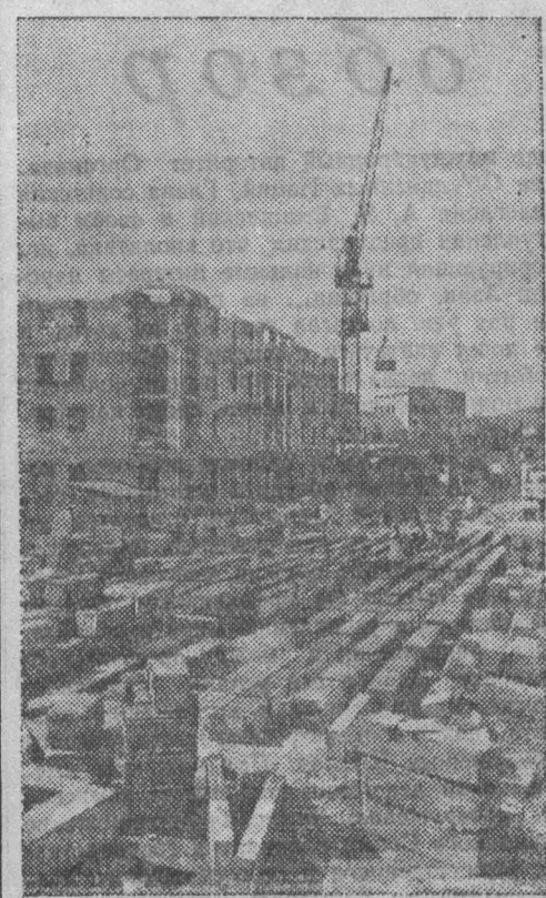
Краснодарский край. Строители города Сочи разработали и освоили производство блоков и монтажных стен из нового материала — крупнопористого бесчешуйчатого бетона. Для изготовления бетона применяется морская или речная гравий или щебень (известняка) и цемент. На кубометр бетона расходуется 90—130 килограммов цемента.
