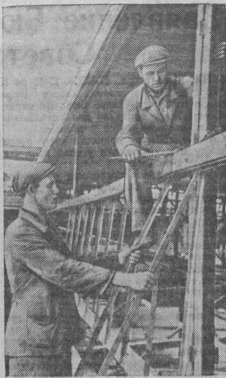
Кузнецкий металлургический комбинат. На строительстве цехов ширпотреба хорошо трудятся монтажники В. Д. Кириенко и Н. И. Чушкин. Своим смелым заданием они систематически выполняют на 130—140 процентов. НА СНИМКЕ: В. Д. КИРИЕНКО (слева) и Н. И. ЧУШКИН за работой. Фото В. Александрова.
