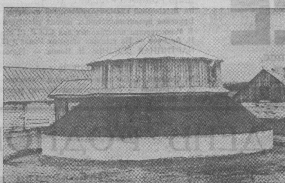
Выполняя решения партии и правительства об обеспечении скота кормами, в колхозе «Гигант», Беловского района, недавно сооружена силосная полубашня на 110 тонн. В порядке шефской помощи ее построил коллектив Беловского строительства треста «Беловуголь» под руководством мастера И. А. Трошкина. НА СНИМКЕ: силосная полубашня в колхозе «Гигант».
