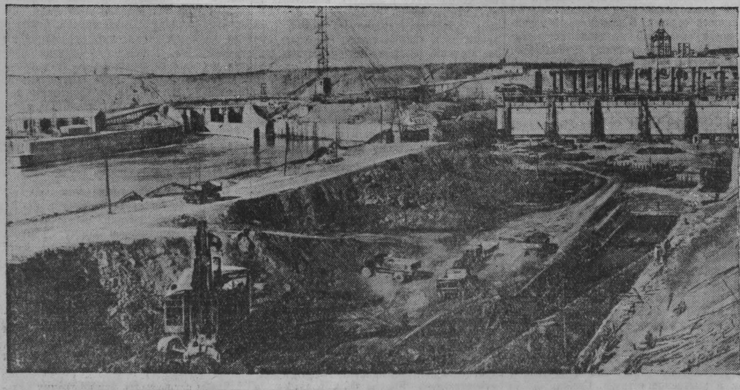
Азербайджанская ССР. Строительство Мингечаурской гидроэлектростанции, которая должна войти в действие в 1953 году. На сооружении гидроэлектростанции работает новая советская техника. НА СНИМКЕ: строительство главного здания и стоводящего канала. Фотохроника ТАСС.
