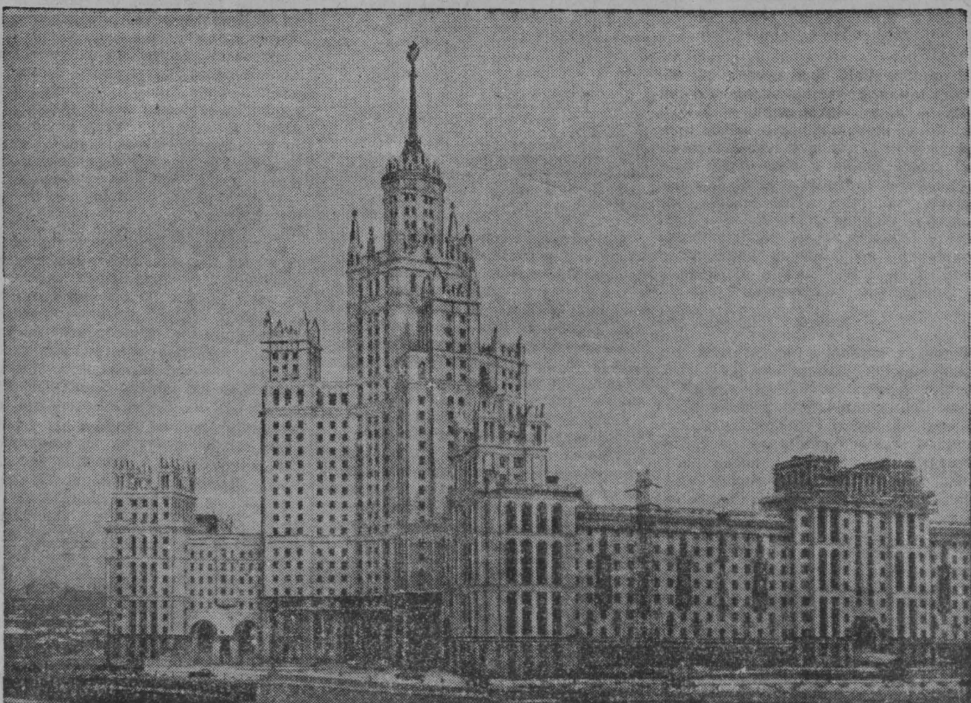
МОСКВА. Строительство высотного здания на Котельнической набережной.
