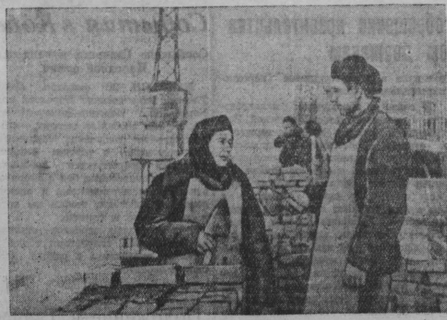
Полным ходом идет строительство здания Сенинковского горного техникума. В мае будет закончена кладка и начнутся отделочные работы. НА СНИМКЕ: лучшая бригада каменщиков П. Е. Демидова, выполняющая по полутора—две нормы. На переднем плане депутат городского Совета каменщик тов. А. С. ЛОБАНОВА (слева) и бригадир тов. П. Е. ДЕМИДОВ. Фото П. Костюкова.
