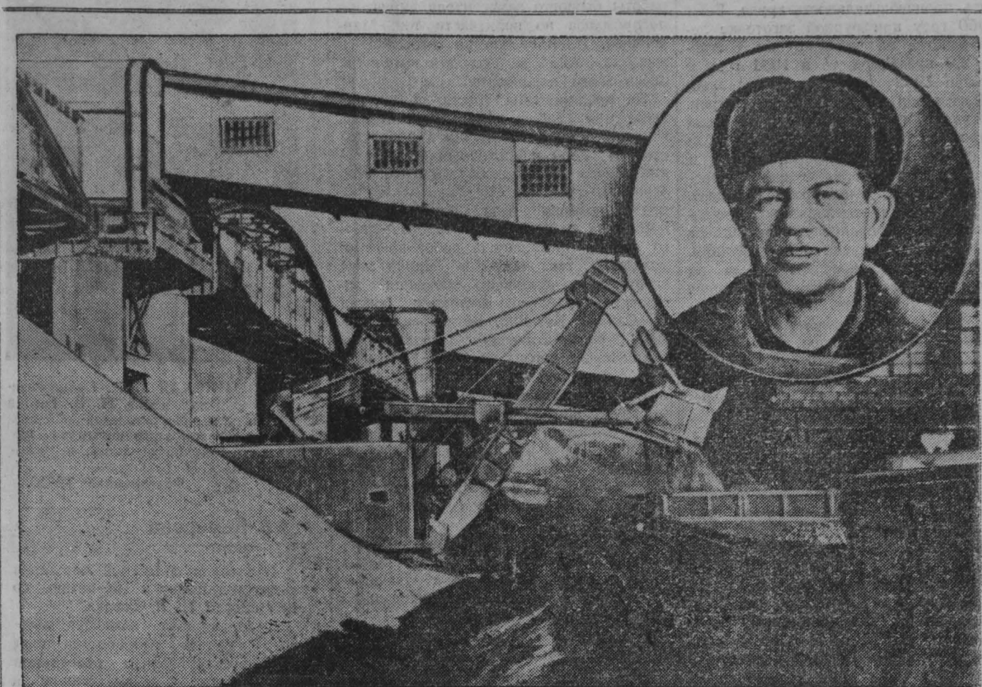
На Таштагольском руднике широко внедряется новая советская техника. Работа по погрузке руды выполняется экскаваторами. НА СНИМКЕ: погрузка руды в вагоны, в овале — старейший экскаваторщик П. К. КАНЦЕДАЛОВ, ежедневно выполняющий по полторы-две нормы. Фото П. Костюкова.
