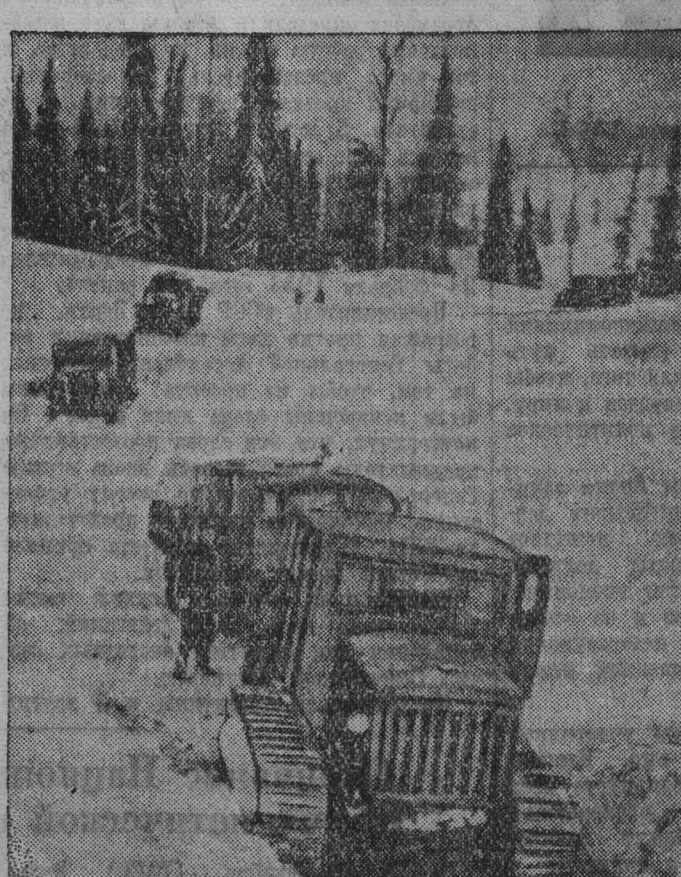
В первые месяцы стройки, когда подвесные дороги еще не были готовы, путь грузовым автомобилям прокладывали по снежной целине тракторы.
