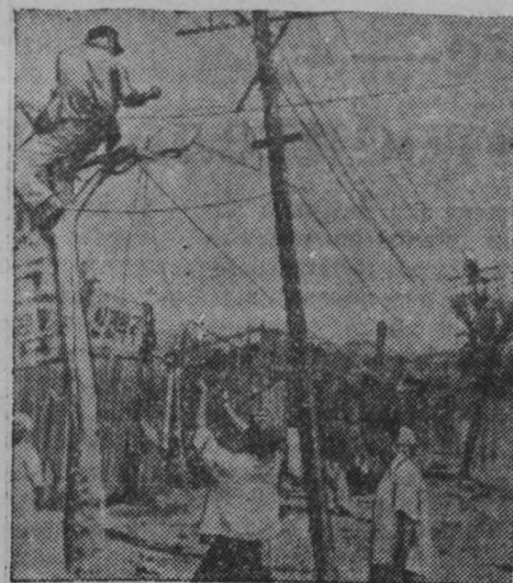
Северная Корея. Американская авиация подвергает непрерывным варварским бомбардировкам столицу Кореи — Народную Демократическую Республику — Пхеньян. НА СНИМКЕ: электрики и связисты восстанавливают линию электропередачи.
