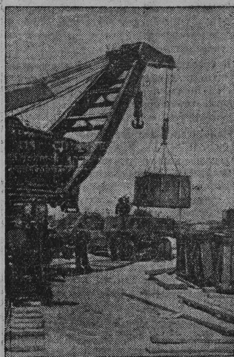
На станции Тахта-Таш ежедневно поступают материалы, машины, станки для строительства Главного Туркменского канала.
