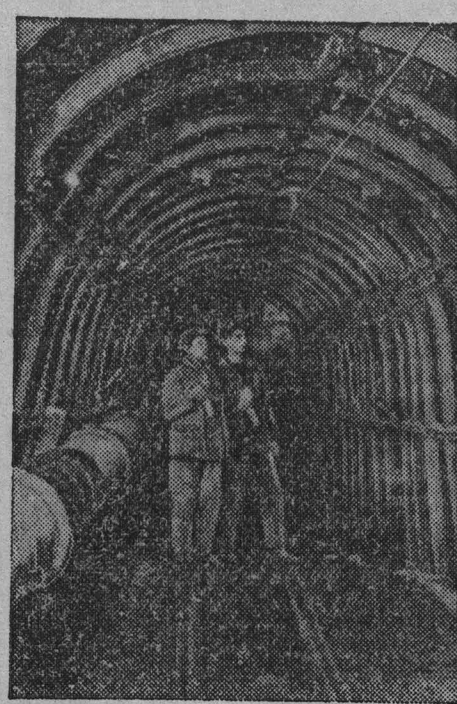
Ростовская область. В шахте шахт комбината «Ростовуголь» внедряется металлокрепление. Новый способ крепления дает возможность улучшить состояние горных выработок, сократить расход крепящего леса.
