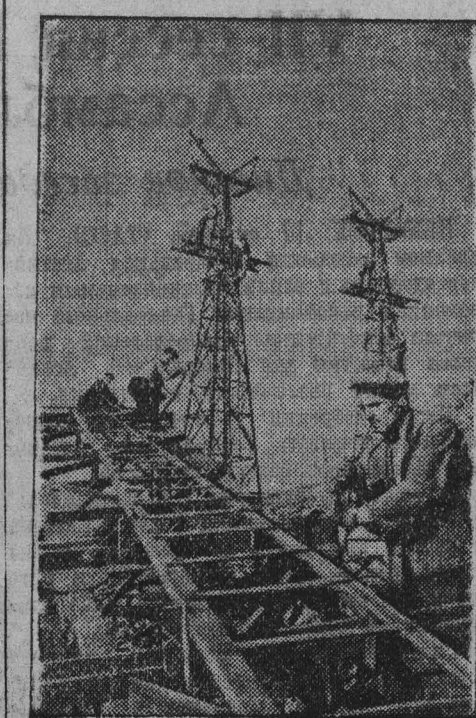
Куйбышевгидрострой. Монтаж мачт-опор для подвесной дороги, которая соединит районы строительства Куйбышевской гидроэлектростанции, расположенные на обоих берегах Волги. На переднем плане — бригадир монтажников М. СОБОЛЕВ за сборкой узлов мачты-опоры. Фотохроника ТАСС.
