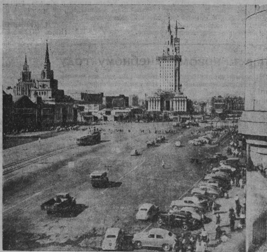
МОСКВА. Строительство высотного здания гостиницы на Комсомольской площади.
