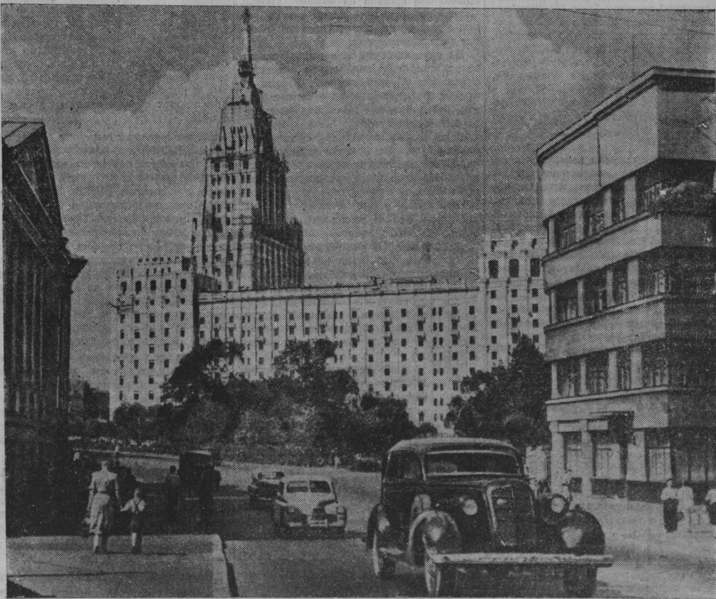
МОСКВА. Вид на строящееся высотное здание Министерства путей сообщения со стороны Ново-Басманной улицы. Фотохроника ТАСС.
