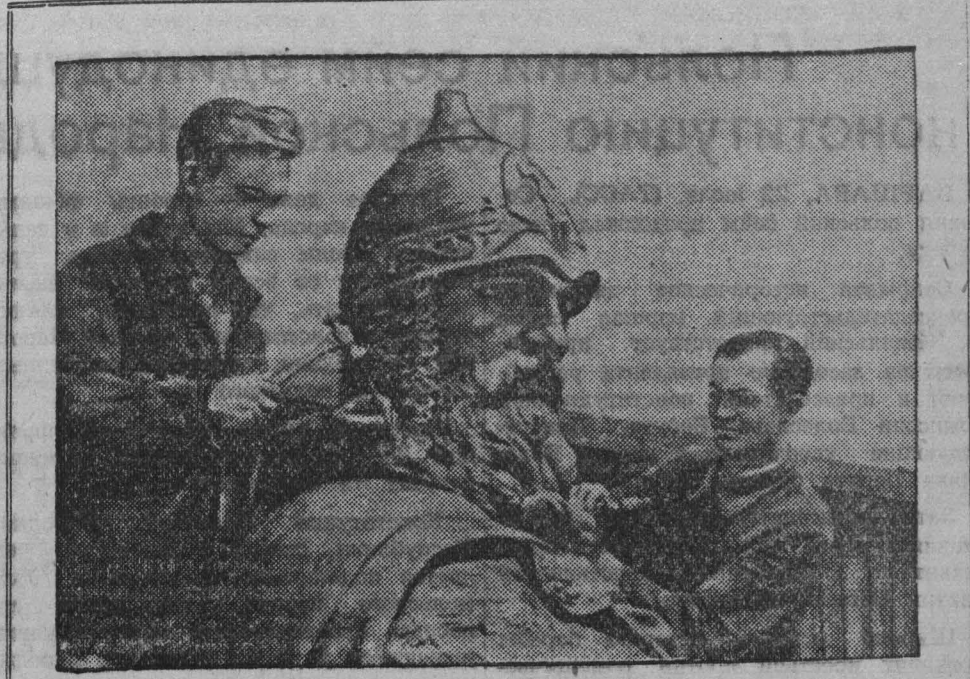
В Мытищах на скульптурно-художественной фабрике № 3 отливаются из бронзы памятники основателям Москвы Юрию Долгорукому, который будет воздвигнут на Советской площади Москвы. Уже отлита верхняя часть фигуры. Коллектив фабрики обязался полностью закончить памятник в начале августа.
