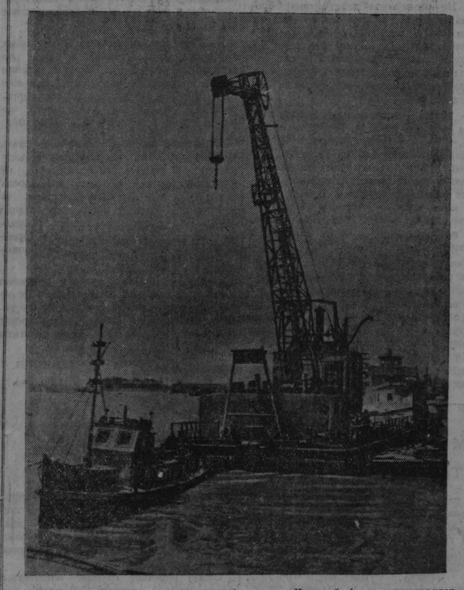
РО. ТОВ-НА-ДОНУ. Судоремонтный завод «Красный флот» изготовляет пловучие заправочные станции и подъемные краны для Цимлянского порта.
