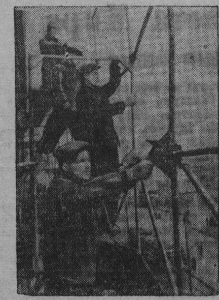
На строительстве культурно-бытовых и жилищных объектов по-стахановски трудится бригада монтажников стройучастка № 3 треста «Проктобасс» шахтострой, руководимая А. М. Стебаевым.
