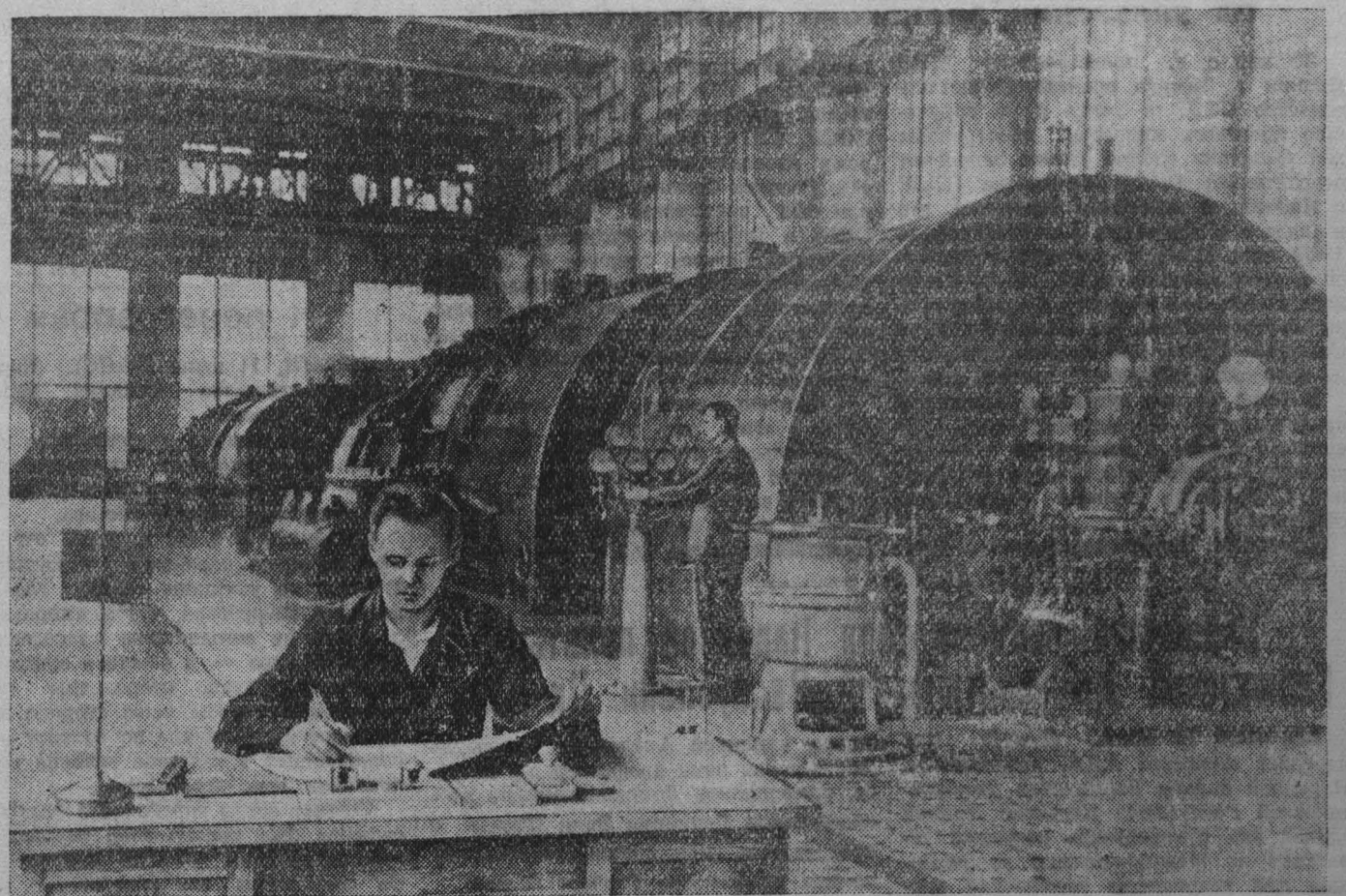
МОСКОВСКАЯ ОБЛАСТЬ. В июне исполнилось 30 лет со дня пуска Каширской ГРЭС имени Л. М. Кагана. Эта станция сооружена по знаменитому ленинскому плану ГОЭЛРО. Став на стахановскую высоту в честь своего юбилея, каширские энергетики обеспечивают высокие технико-экономические показатели в работе. Коллектив станции добился значительного увеличения выработки электроэнергии и экономии топлива.
