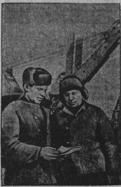
Стахановской работой встречают предмайские праздники шахтеры Краснобобовского разреза. Бригада И. М. Ползукова дала слово к 1 мая, на 10 дней раньше срока, закончить монтаж трехкубовых электрических самодвижителей.
