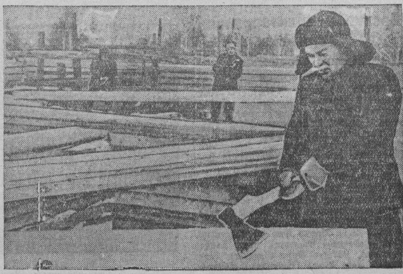
В Киселевском районе строятся новые дома. На снимке — бригада плотников Ивана Ефимовича Зуева на стройке нового районного Дома культуры. В Доме культуры будут оборудованы зрительный зал на 400 мест, стационарная киностановка, библиотека с читальным залом. Фото И. Прудникова.
