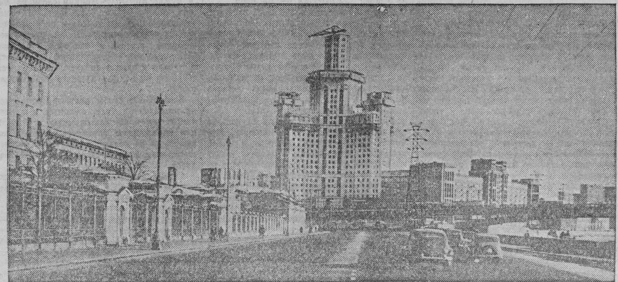
МОСКВА. Строительство высотного здания на Котельнической набережной.
