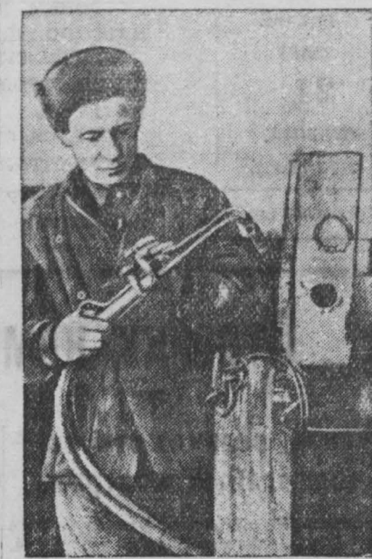
В Кузнецкой МТС ускоренными темпами идет ремонт комбайнов. На снимке: электросварщик тов. С. РОМАНЕНКО за сваркой деталей. Фото В. Бульчева.
