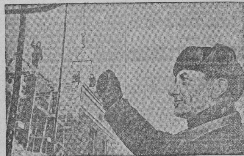
Башенный кран — замечательная машина, позволяющая полностью механизировать горизонтальную и вертикальную транспортировку грузов на стройке. Целые узлы зданий, контейнеры с кирпичом и ковши с раствором быстро поднимаются этим краном с земли и опускаются в любой угол строящегося здания, во много раз ускоряя и облегчая работу строителей. На стройках г. Сталинска работает уже более десятков этих мощных машин. Управление ими требует большой сноровки и опыта.
