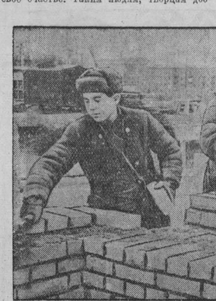
Большой известностью у строителей треста «Сталинскпромстрой» пользуется молодежная бригада Ивана Белика. Коллектив бригады ежедневно выполняет свое производственное задание на 140 — 150 процентов.
