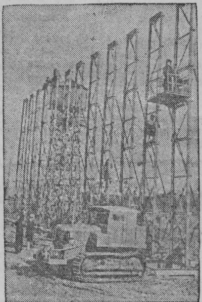
Новосибирск. Заводу строительных машин поручено изготовить для строительства Куйбышевской гидротрестации партию мачтовых подьемников.
