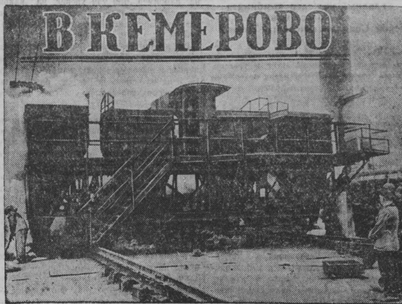
Загрузка печей на Кемеровском коксохимическом заводе. Фото Л. Великжанина.
