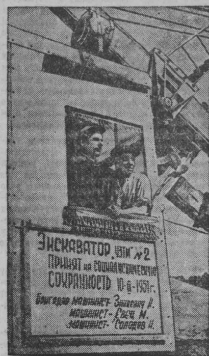
Среди экскаваторщиков Куйбышев-гидрострой широко развернулось социалистическое соревнование за досрочное выполнение заданий, за лучшее использование механизмов. Среди соревнующихся хорошо работает бригада Н. Зинкевича. Экскаваторщик выключает по полторы—две нормы. НА СНИМКЕ: машинист экскаватора Н. ЗИНКЕВИЧ (слева) и Н. СОЛДОВ. Фото М. Крайнекова. (ТАСС).
