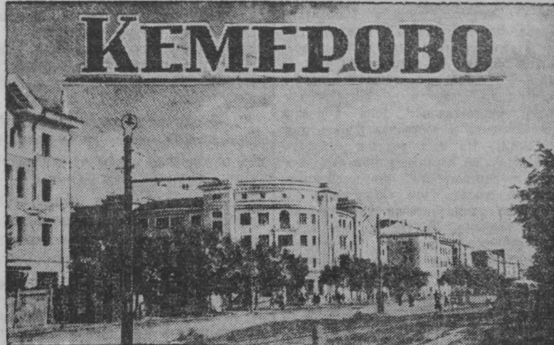
Новые здания на Советской улице, в районе ее пересечения с улицей Весенней. Фото П. Костюкова.
