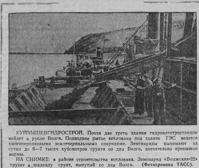
КУПЬШЕВГИДРОСТРОИ. Почти две трети здания гидроэлектростанции войдет в русло Волги. Подводное рывье котлована под здание ГЭС встанет многоэтапными землетрясениями снарядями. Земснаряды вынимают за сутки до 6—7 тысяч кубометров грунта со дна Волги, значительно превышая нормы.
